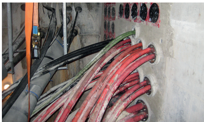
Après rénovation des passages en attente ont été créés. Des fourreaux scindés ont été placés autour des câbles existants, garantissant l'étanchéité entre le mur et les câbles.
