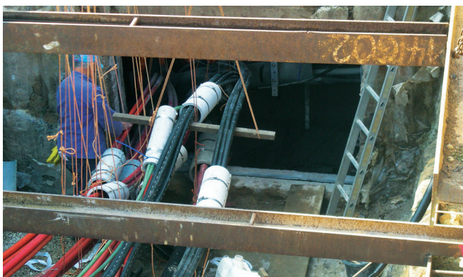
Un espace a été dégagé autour de chaque tubes et câbles afin de pouvoir intégrer dans le mur les fourreaux fibrociments scindés.
