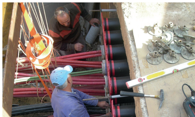
Montage de passages étanches HSI 150-K2 et des fourreaux fibro-ciments scindés FZR-G.
