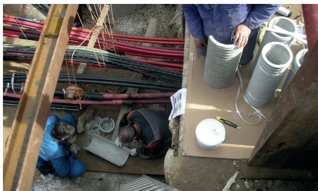
Montage des fourreaux en fibrociment scindés FZR-G.
