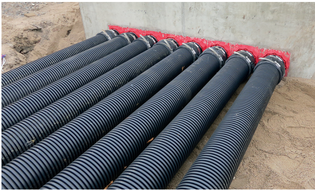
Anbindung der Leerrohrtrasse mittels Manschettenteknik
