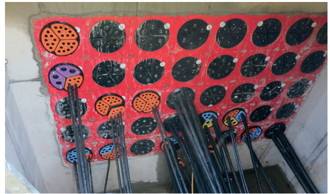
HSI 150-K2 als Paketanordnung und Abdichtung mit Systemlösung Segmento und HSI 150-DG
