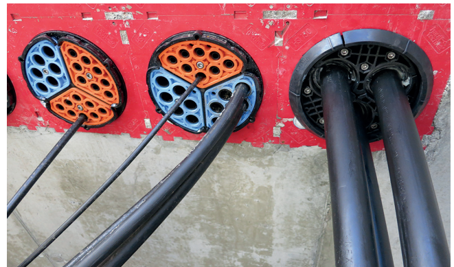
Abdichtung mittels Segmento und HSI 150-DG
